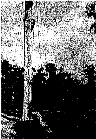
ショウピアパイロット伐出センターにおける実習(元柱作設)
