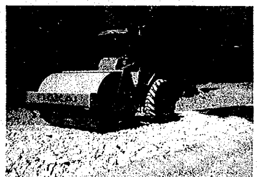
ローラーによる転圧
