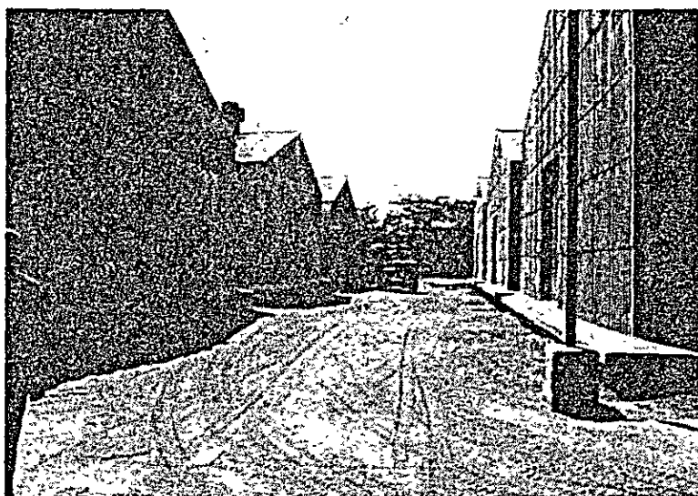
同上籾倉庫群、通路は未舗装 (同上)
