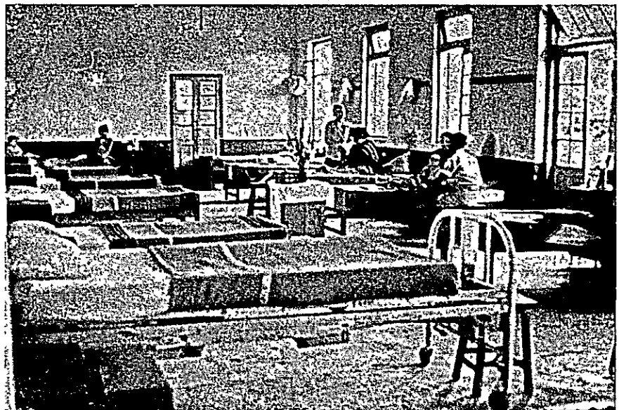
ロイレムにおける 市民病院の内部 →
