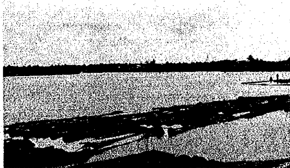
訓練橋（THUWUNNA 橋）架橋地点より 下流側を望む
