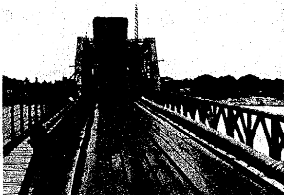
旧タケタ橋 (元鉄道橋を現在道路橋として使用, 信号による交互一方通行規制を行っている)
