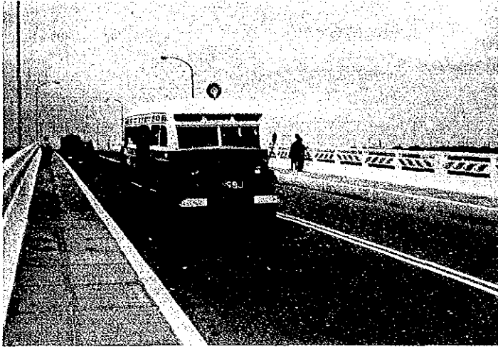
4. ツワナ橋の交通状況
