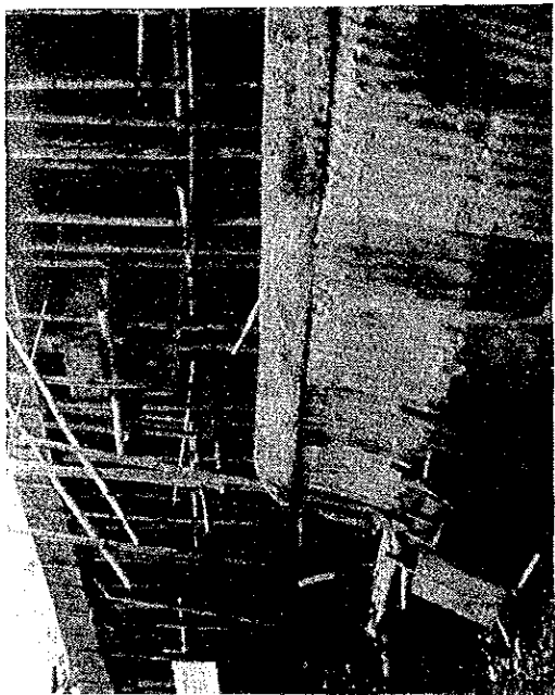
二階床版の型枠の支持 建築現場(1)
