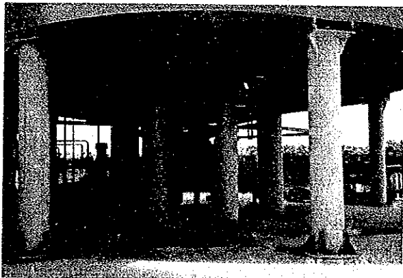
写真-21 CEMENT SILO の底部
