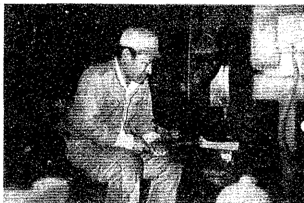
写真13 スプリングハンマーによる 汎用中厚鎌の火造り 中央部から刀柄部へ向って荒伸しをする
