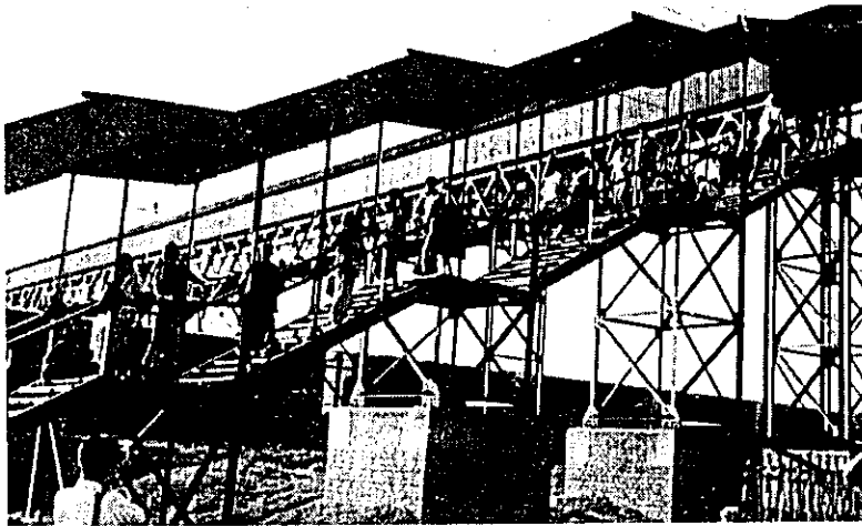
老朽化しているこ線橋
