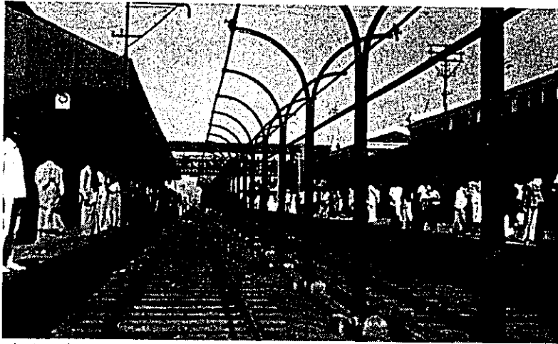
客車屋根冷却用撒水設備（主要駅にある）
