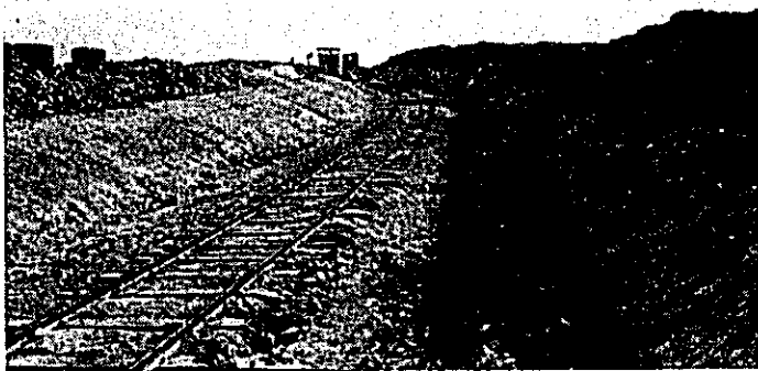
(写真Ⅲ-12) 貨車乗込の線路道床 バラストなど何処にもない
