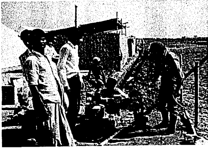
基地の建設作業
