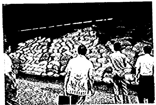
フィリピン ダバオ港の港頭倉庫
