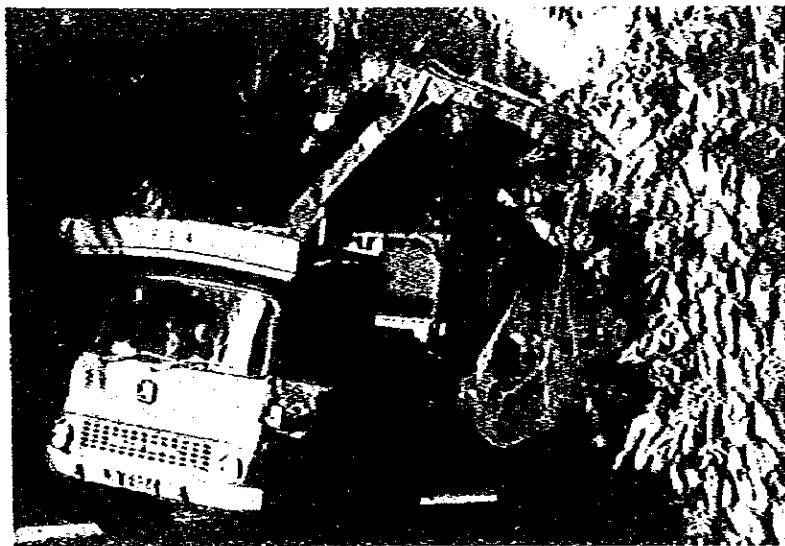
写-40 クレーン車による果房積み込み
