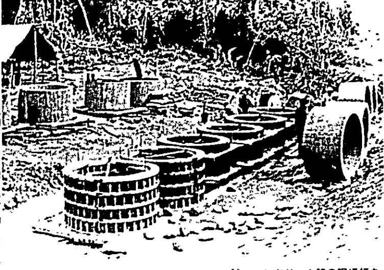
26 コンクリート管の現場打ち
