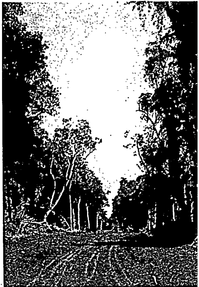
原始林の中の道路敷設状況 (パラグアイ・アルトパラナ入植地)
