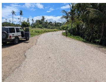
舗装状態が良好な区間
