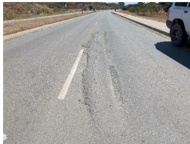
写真 11: POM 市内（交通量の多い区間）のわだち掘れ発生状況
