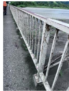
歩道部手すり
