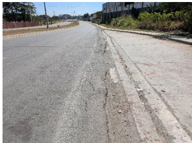
写真 11: POM 市内（交通量の多い区間）のわだち掘れ発生状況
