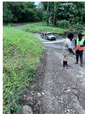
前後の道路勾配が急な箇所
