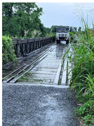
Siang Bridge を通行する車両
