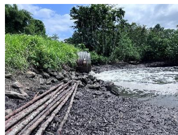
パイプカルバート（BP） ベイリー橋に併設
