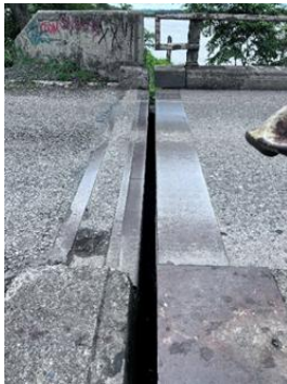
A1側伸縮継手
