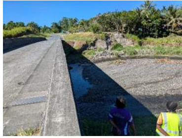
河川の斜面崩壊 橋梁名 Pularobi-2 Br.
