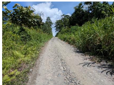
未舗装区間（砂利主体）
