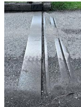
A2側 伸縮継手
