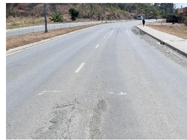
写真 11: POM 市内（交通量の多い区間）のわだち掘れ発生状況
