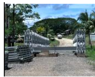
復旧（ベイリー橋）
