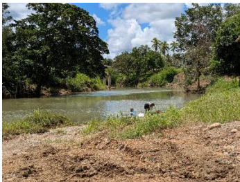
落橋した旧橋
