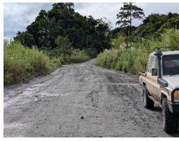
未舗装区間（山岳区間）
