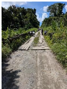
木床版の非常に古いベイリー橋（構造的には安定）
