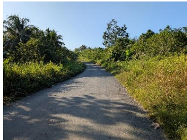
道路状況（舗装済み）
