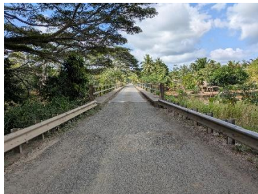
1車線の標準的な橋梁
