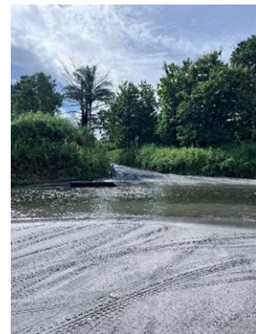
前後の道路勾配が小さい箇所
