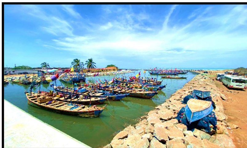
図 4-13 対策実施例 Komenda Coastal Protection Project
