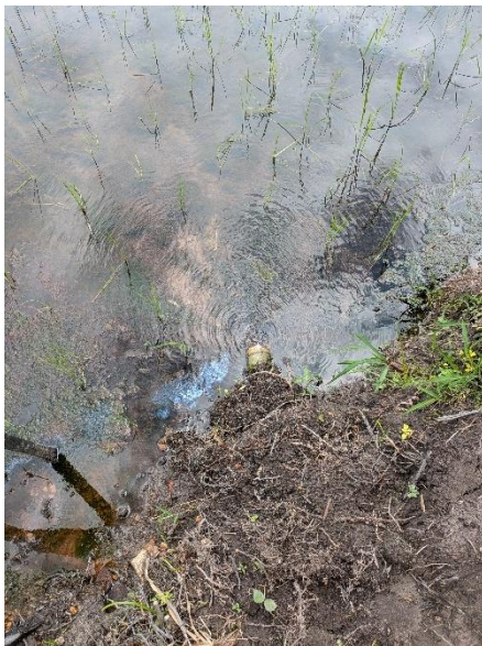
IVS の取水口（取水管が竹筒でできている）
