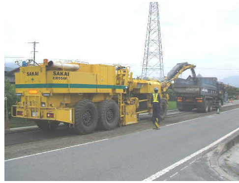
図 3.21 路面切削機による路面切削
