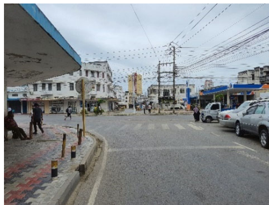
交差点中央部にある小規模なラウンドアバウト （撤去予定） スマートシティプロジェクトのカメラポールや 電力設備が設置してある。
