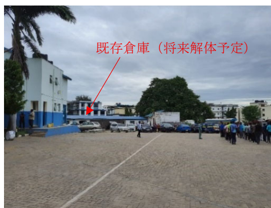
既設交通センター（左側 2 階建て）と 新しい交通管制センターの建築予定地 （隣の 1 階建て倉庫を撤去し新設予定）
