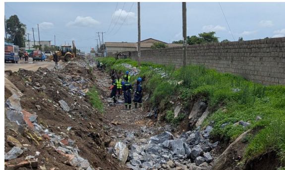
Kanyama 地区に整備されている雨水排水路
