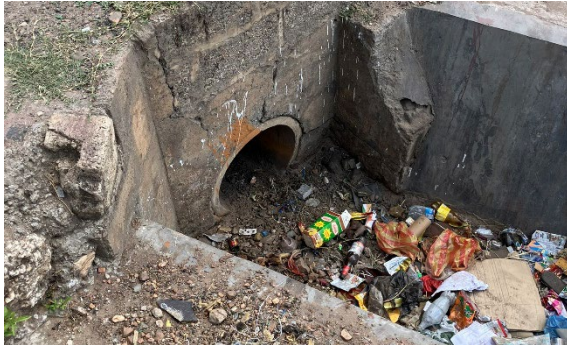
Chaisa 地区の雨水排水路
