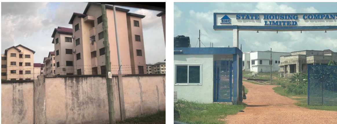
図6.7 SHCによる住宅建設
