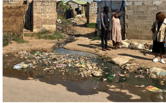
Bauleni 地区で道路に表出する排水
