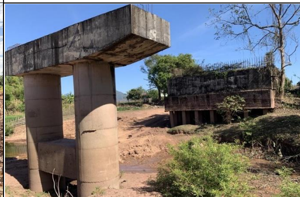
④ 橋梁No.2の工事の状況
