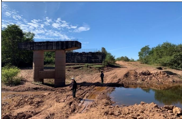
⑤ 橋梁No.2の工事の状況
