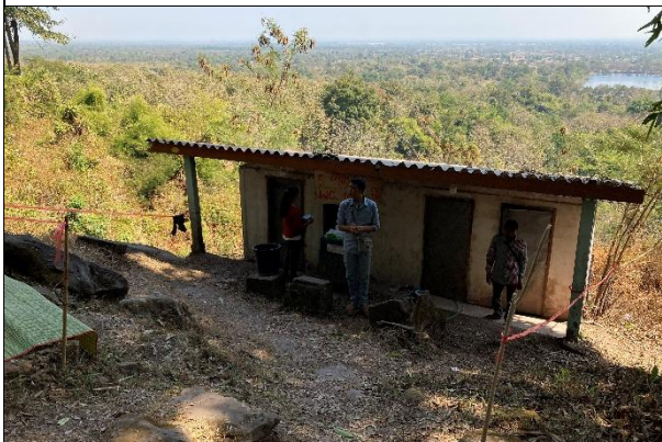
⑦ 至高聖所エリアの公衆トイレ（垂れ流し）
