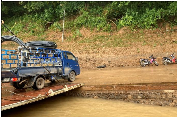
⑤ フェリーの昇降式の棧橋とスロープ式の岸壁の接岸部
