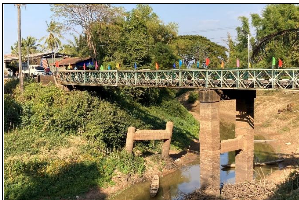
① 既存道路に架かる木製床版の橋梁（大型車両通行不可）
