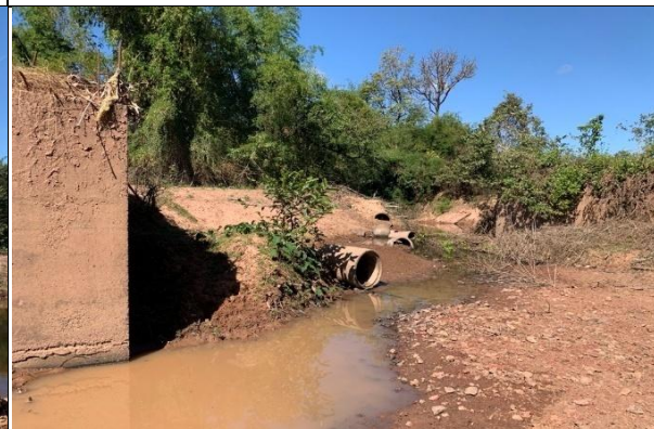
⑥ 橋梁No.3の工事の状況
