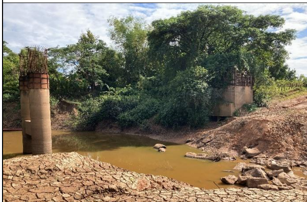
③ 橋梁No.1の工事の状況
