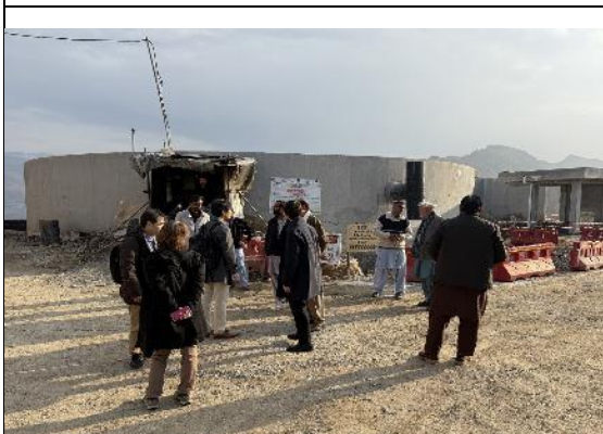
ADB支援により建設中の浄水場視察
