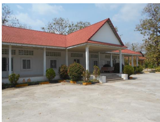
管理棟（RTTC-L 棟）： RTTC キャンパスメインゲートの正面にある管理棟。
