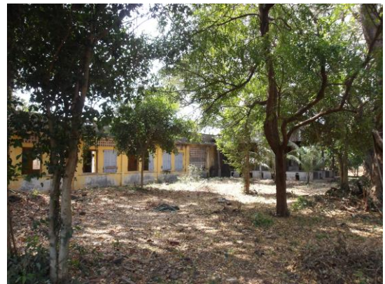
雨水浸透井サイト： 老朽化し使用されていない既存棟があり、解体予定。
