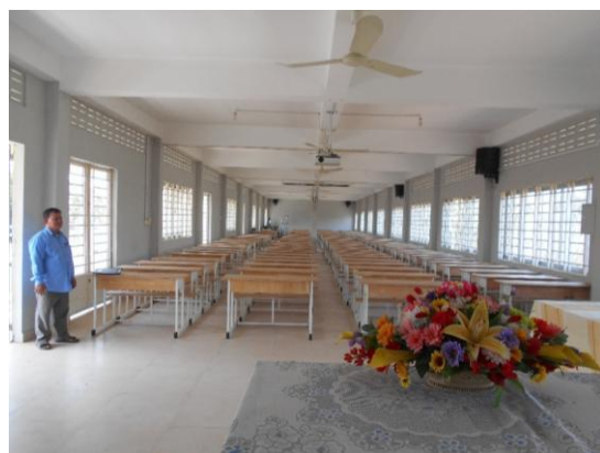
一般講義棟（RTTC-R 棟）： 5 教室の間仕切り壁を外し 250 人収容の講義室・集会場として使用。
