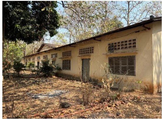
建設用地 A（STEM 棟サイト）： 老朽化し使用されていない既存棟があり、解体予定。
