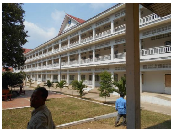
一般講義棟（RTTC-R 棟）： 近年新設された 3 階建ての一般講義棟。
