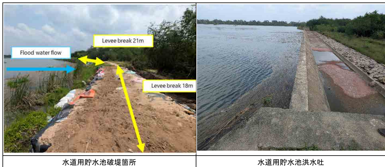
図 3.3.42 Eluwankulama 取水ポンプ場の被害状況（3/3）
