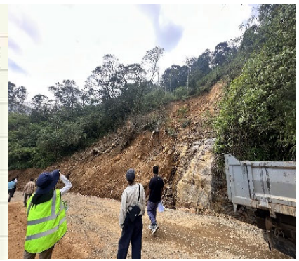
図 3.4.36 表層崩壊の事例 (Matale 県州道 B274)
