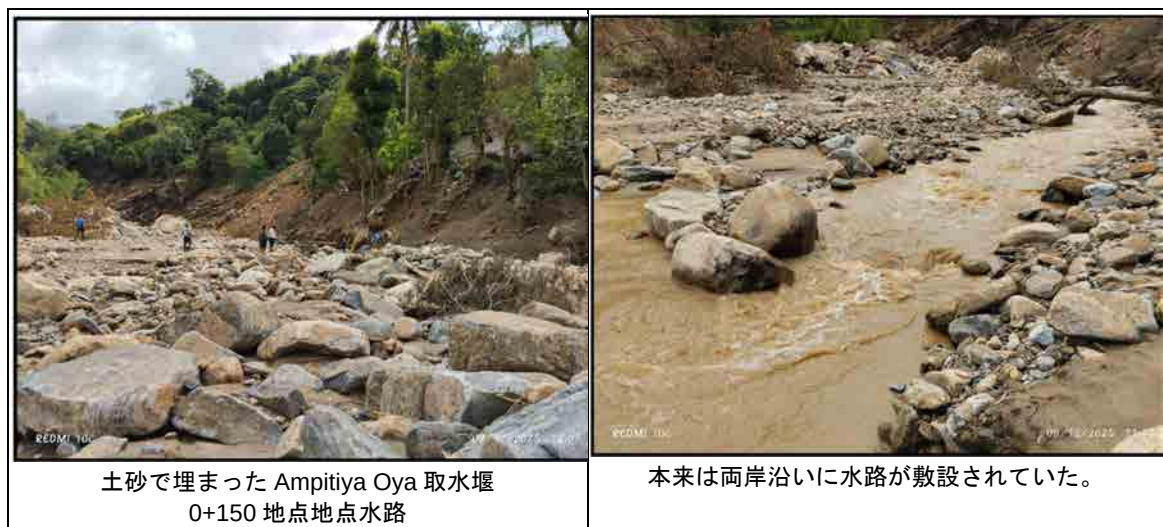
図 3.4.51 Waduawawala 灌漑スキームの甚大な被害が発生した箇所の写真 (1/2)
