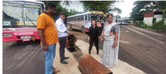
Site Inspection - Kaduwela (2024.08.16)
