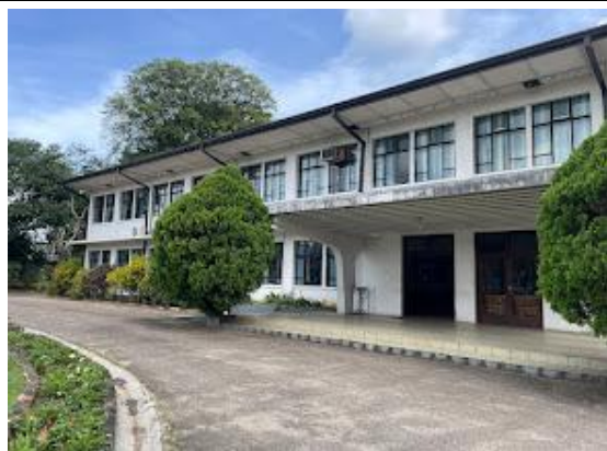
獣医学研究所（VRI）の建屋／2 階建てで手前に各部門の研究室が、奥には CVIC の建屋が配置されている
