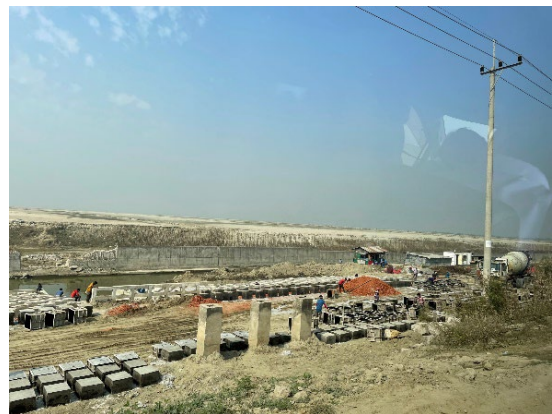
No.10 ベイターミナル建設現場
