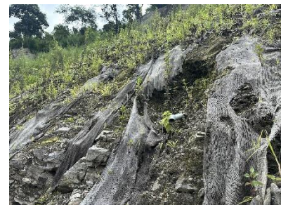
Tekizanpa の地下水排除工
