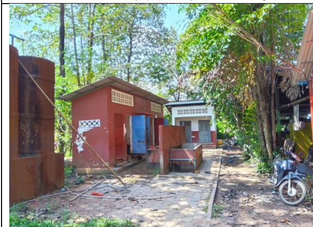
食堂の脇に設置されているトイレ。手前が女子トイレ、奥側が男子トイレ
