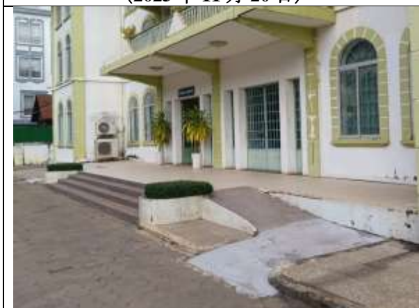
SRWSA 旧庁舎玄関前の車椅子用スロープ (2025年11月27日)
