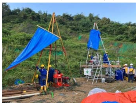
現場状況、左は現地調査会社のチーム 2024/07、チアンジュール現場
