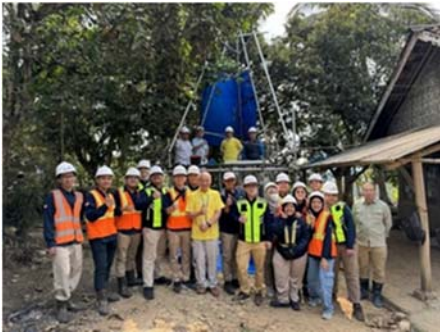
インドネシア地盤工学会関係者による現場見学 2024/08/06、セララン現場
