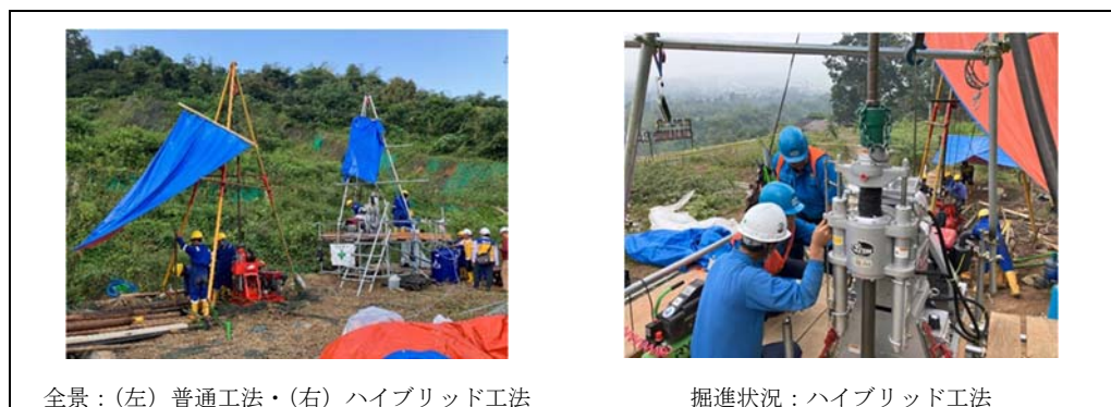
図19 現場作業状況（サイト1 チアンジュール） 提案法人作成
