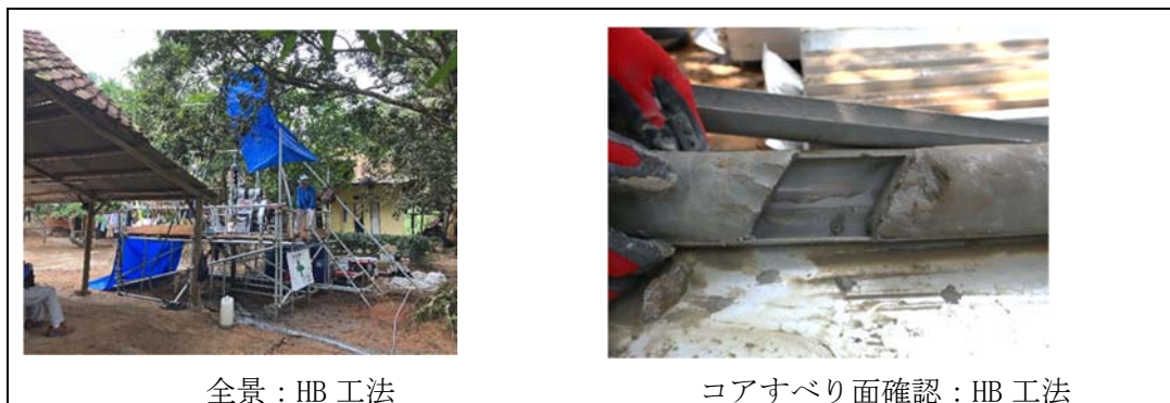
図 22 現場作業状況 (サイト2 セラシ)
