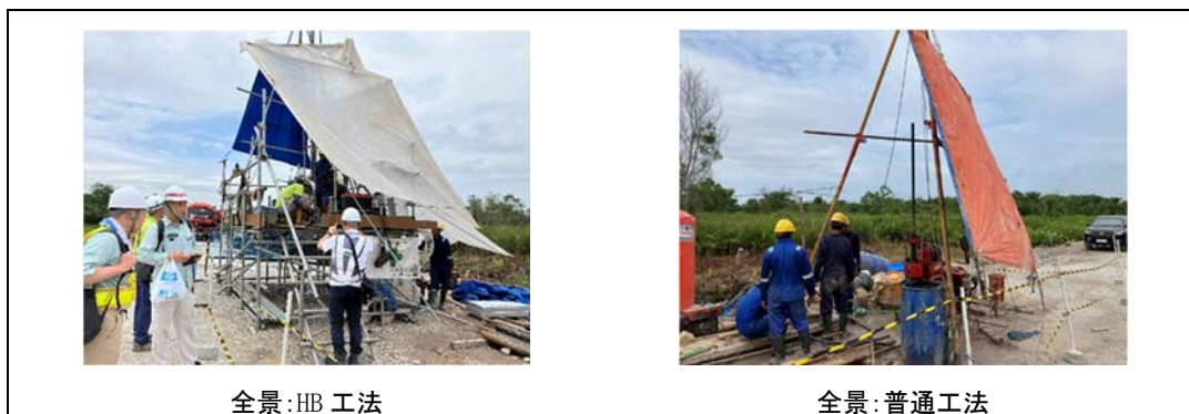
図 25 現場作業状況 (サイト3 ペカンバル)
