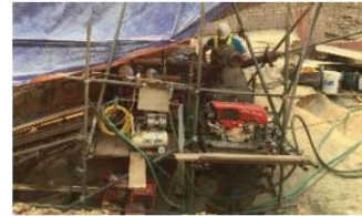
ダムサイトの地盤調査(斜掘り)
