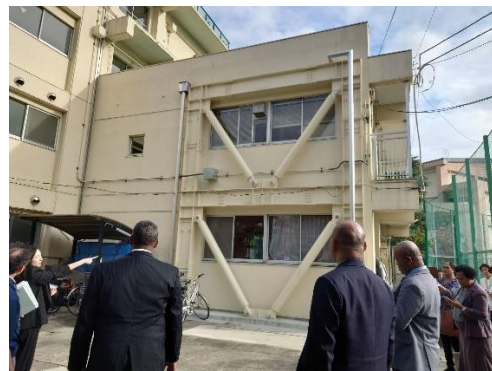
写真 駒留中学校耐震補強工事箇所視察
