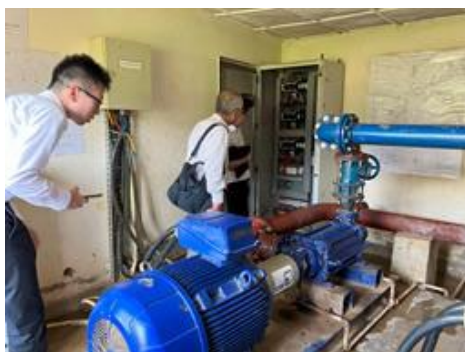
実証試験候補ポンプ場（Ruyenzi 地区*1）視察
