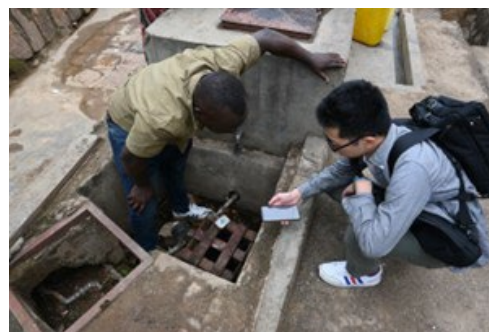
IoT 化圧力計センサユニットの撤収作業
