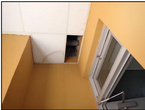
写真5 第一回現地調査で確認した雨漏り箇所（第二回現地調査時には修繕済み）（出典：評価者撮影）
