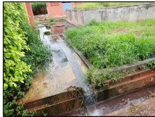
写真 4 浄化槽から排水が流出している様子（出典：評価者撮影）
