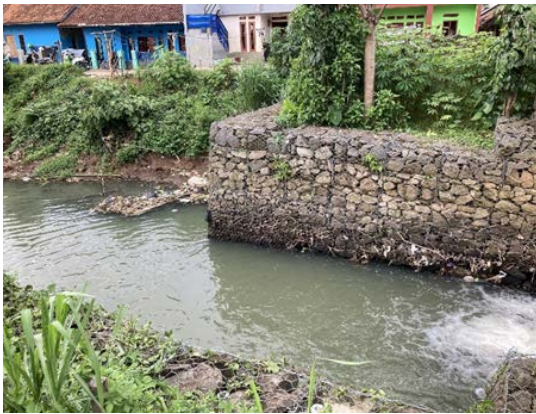
写真6：河川改修工事箇所 （チクルー川：石框 いしがまち を設置） （出典：評価者撮影）
