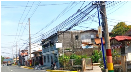
写真3：水位危険度が示された電柱の事例 (イムス川サブプロジェクト)
