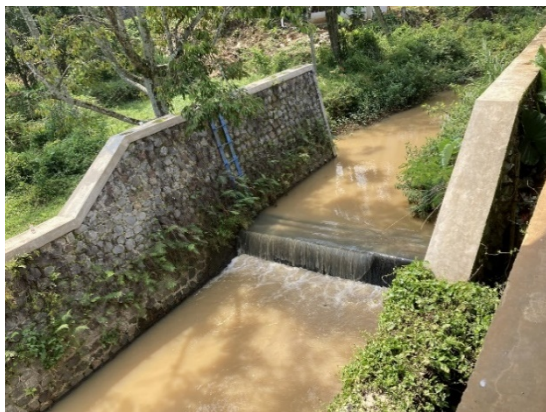
写真 1：砂防堰堤（チラセア川上流域） （出典：評価者撮影）
