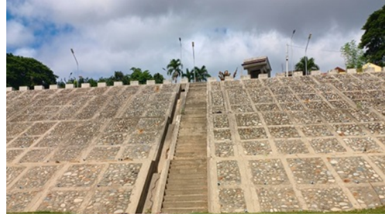
写真4：カガヤン川で整備された護岸壁 (カガヤン川サブプロジェクト)
