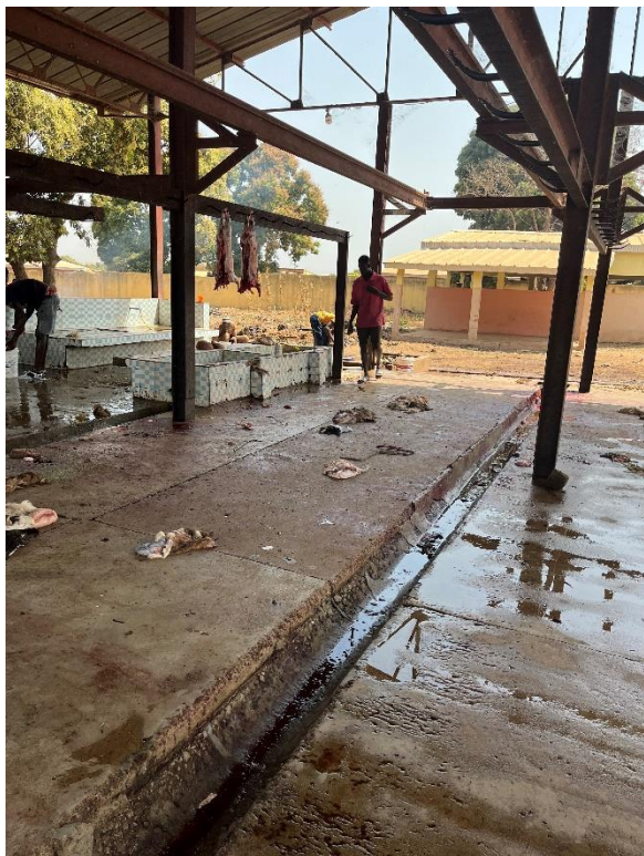
Figure 9.2.8 Espace d'abattage (Carcasses de chèvres attachées à l'arrière, point d'eau à l'arrière gauche)
