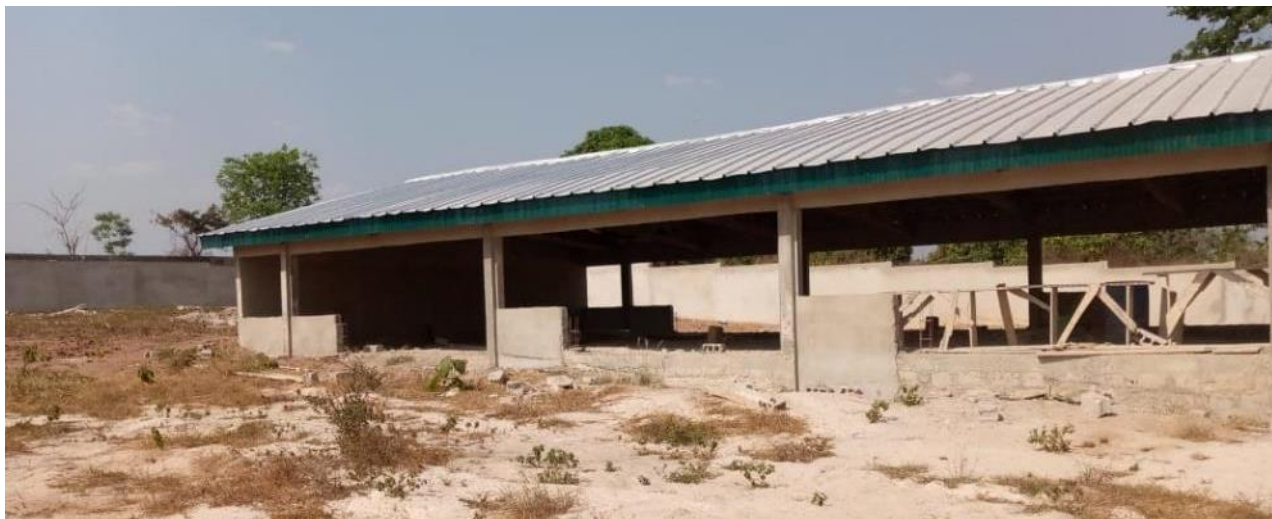
Figure 3.7.2 Marché de Diabo en cours de construction
