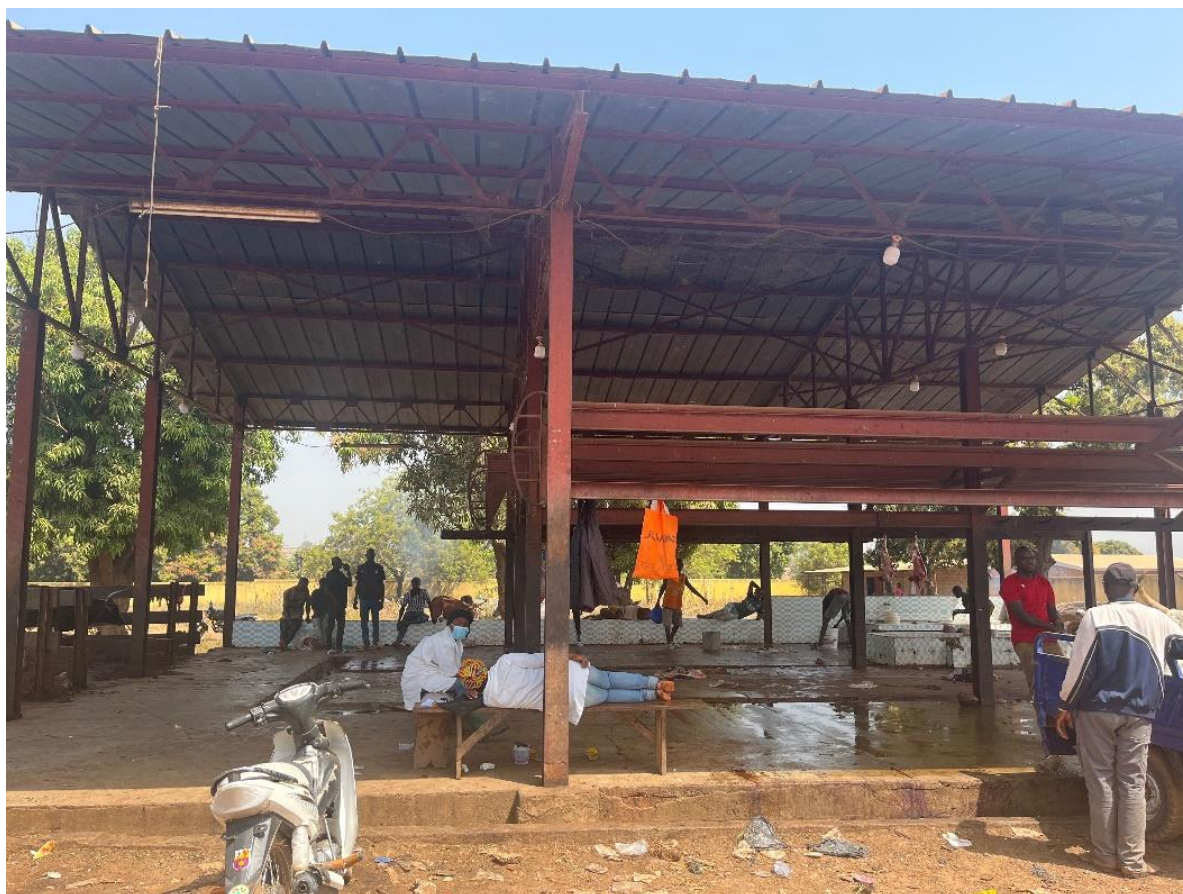
Figure 9.2.7 Aspect extérieur des abattoirs (Structures simples avec seulement un toit et une charpente)
