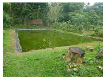
サント島ワイラパコミュニティ養殖池。HDPE養殖シートを使用しているため水漏れも無く池が緑色で非常に安定した状態を保っている
