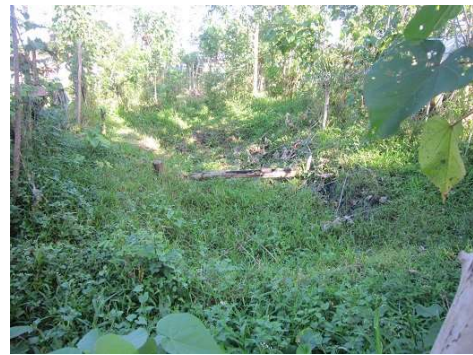
図25 被害を受けて使用できなくなったバックヤード池
