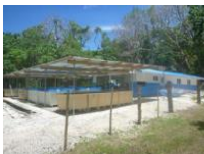
サイクロン・ハロルド後の改修工事が終了したマンガリリウコミュニティ沿岸資源増殖用蓄養センター
