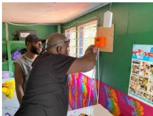
ソーラー冷凍庫設置の様子
