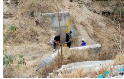
Instalación de una escala para medir el nivel del agua en Santa Rosa de Pomasqui.
