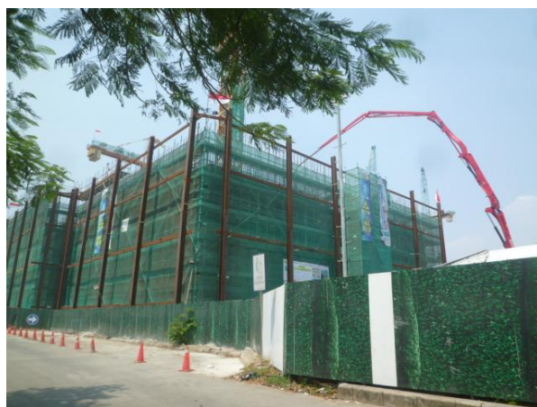
ニューマチック・ケーソン工法による ポンプ施設の建設（p K 1 大林組・JFE JV）
