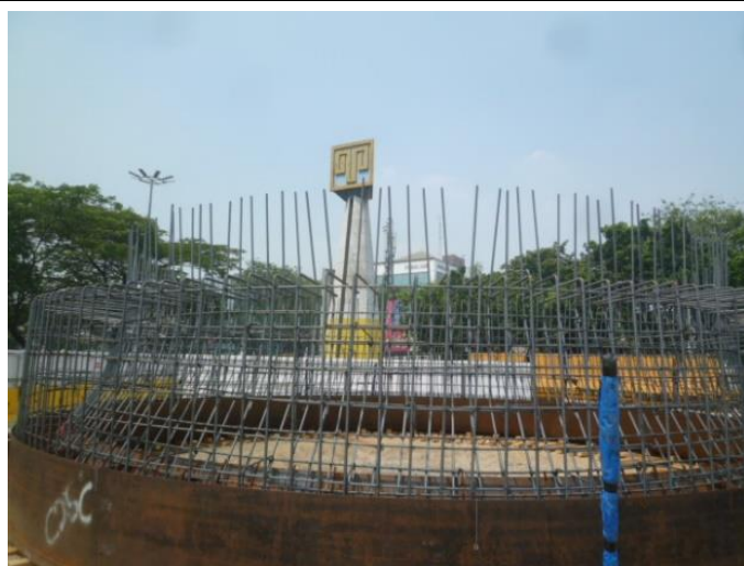
ケーソン刃口鋼材と鉄筋の組立て状況 （この後型枠設置・コンクリート打設）
