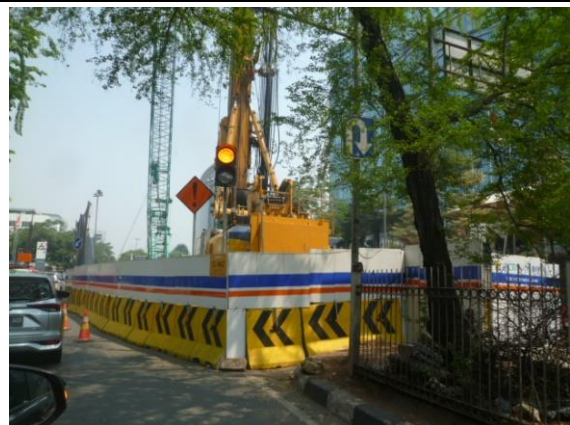
立て坑構築準備作業 C24-2 地盤改良工（重機）と作業帯
