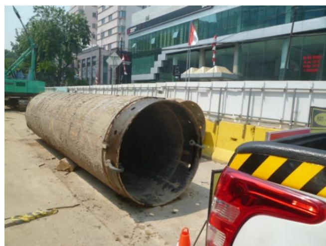
地盤改良（砂置き換え）のための ケーシング
