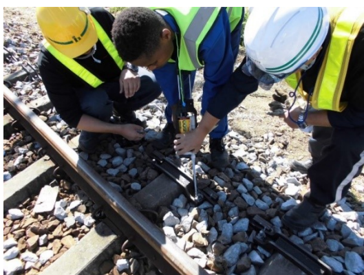
座屈防止板の設置
