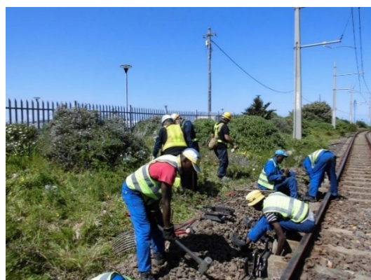
座屈防止板の設置
