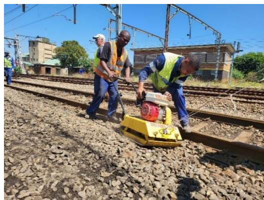
座屈防止板の設置後の整正
