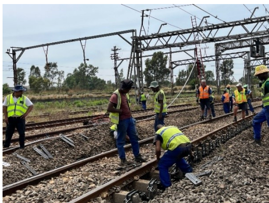
座屈防止板の設置
