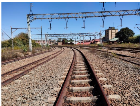
Germiston 駅近傍設置箇所
