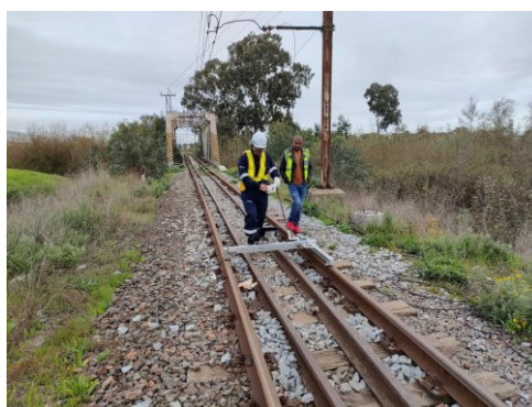
座屈防止板設置の後の計測
