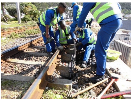
座屈防止板の設置
