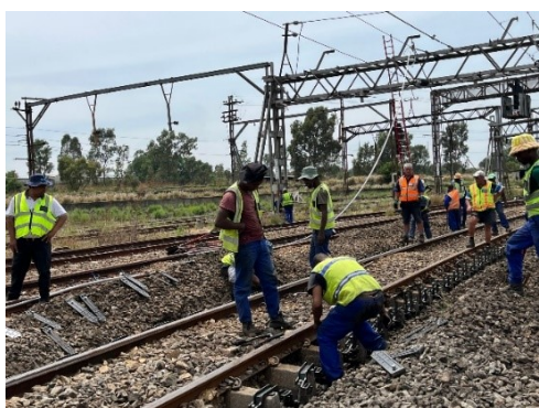
座屈防止板の設置
