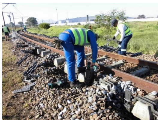
座屈防止板の設置
