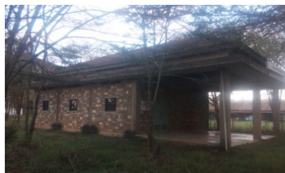
据付前のサイト建屋 (2022 年 7 月撮影)
