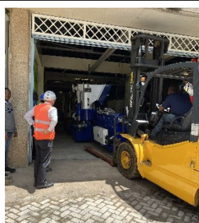
押し出し機の積み降ろし・据付 (2023 年 11 月撮影)
