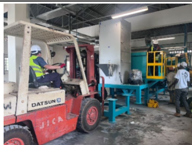
洗浄脱水機の積み降ろし・据付 (2023 年 9 月撮影)
