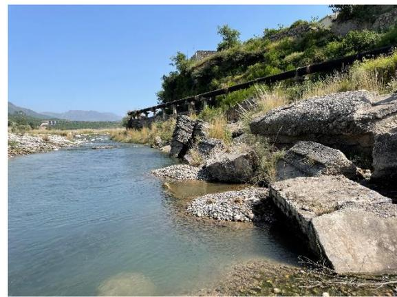
破損した護岸 (Mohra Ghazan 地区)
