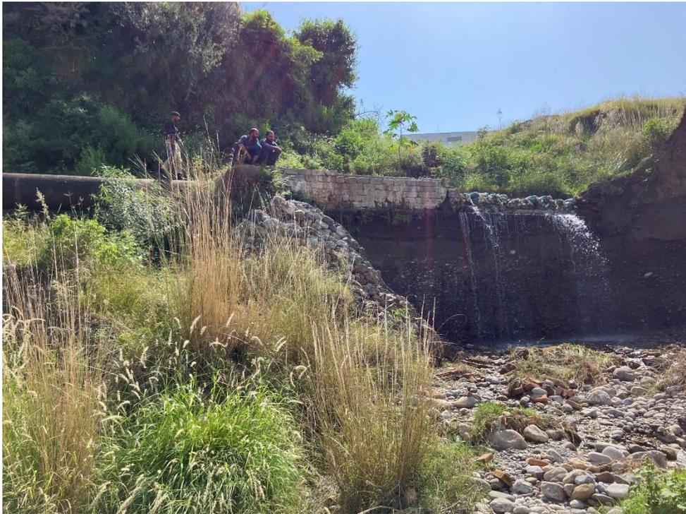
図 6.2.18 Mohra Ghazan 地点の被災した護岸 (2023 年 10 月撮影)
