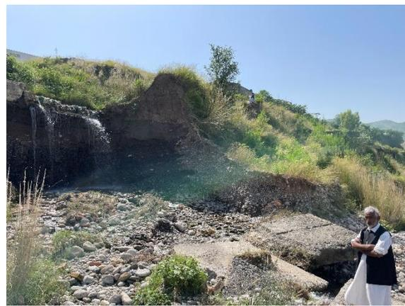
破損して水漏れしている灌漑用水路
