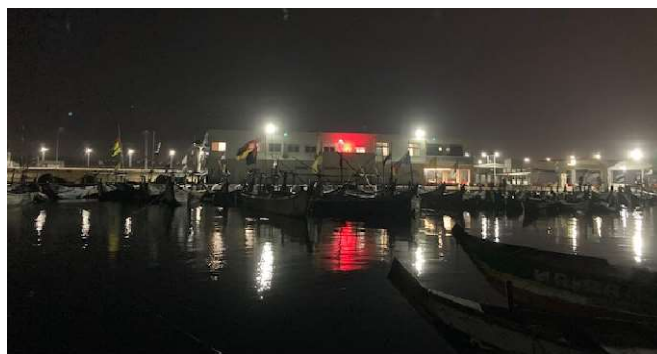
Photo 3-5 Projection sur le mur du bâtiment administratif de l'éclairage rouge LED pour alerter des conditions hydrographiques
