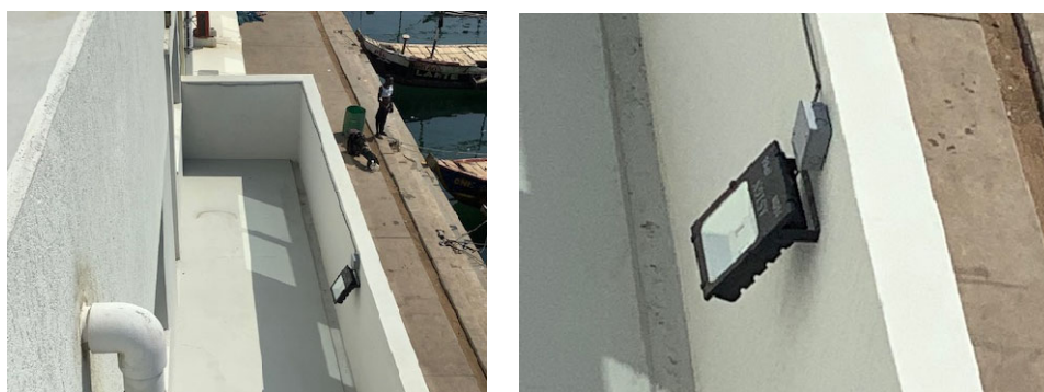
Photo 3-4 Installation de l'éclairage sur le balcon du 2 ème étage du bâtiment administratif du port de pêche de Lomé
