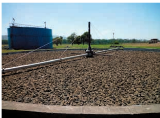
ナクル・タウン下水処理場の散水ろ床（ケニア）
