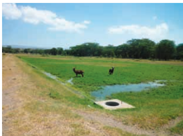
ナクル・タウン下水処理場のグラスプロット床に侵入中の野生生物達(ケニア)
