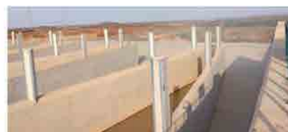
Déversoir en forme de triangle (labyrinthe)
