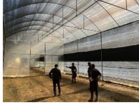
「16m×8m の栽培室」が 3 室ある栽培工場
