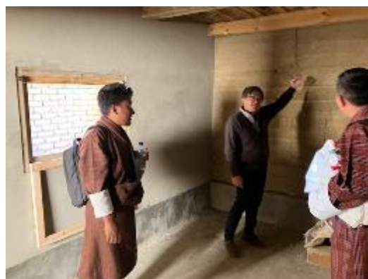
接種室（建設中）
