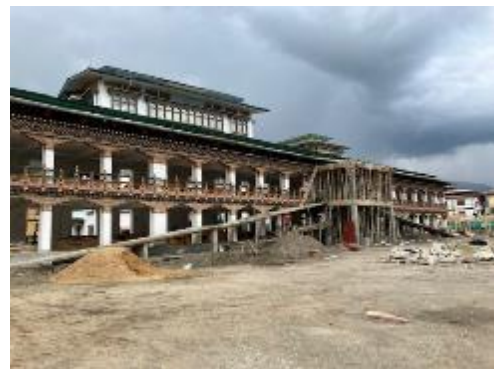
建設中のパロ県青果市場
