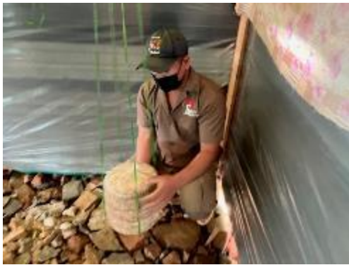
ブロック吊り作業 2
