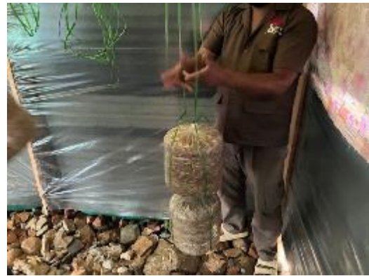
ブロック吊り作業 3
