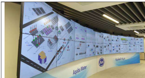
[写真-1] AWC の SCADA 中央監視室
