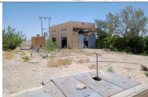
[写真-4] New Tahounch 配水ポンプ場
