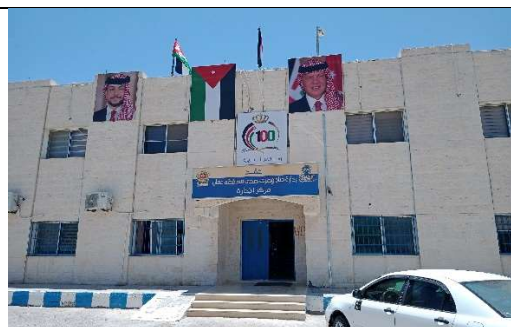
[写真-2] Wa Ma'an 庁舎（本プロジェクトで Ma'an SCADA 中央監視室を設置する）
