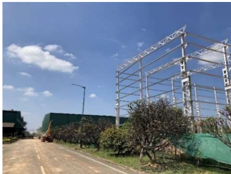
E 社（現地鋳造メーカー）の建設中 の新工場建屋（2022 年 11 月）
