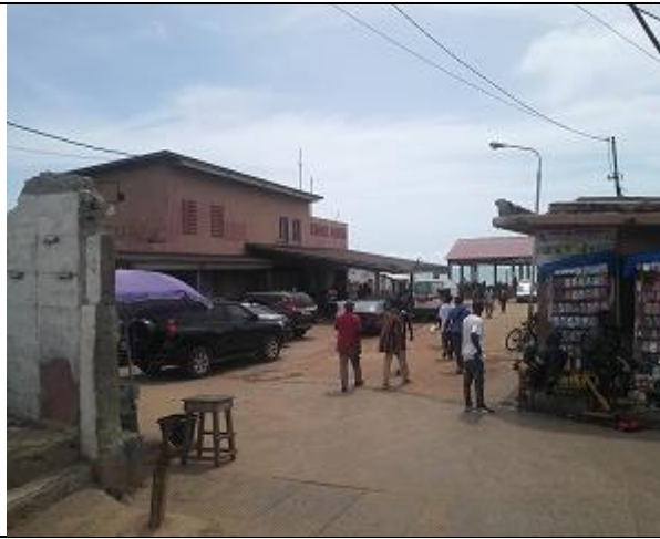
正面入口から望む水揚場の全景
