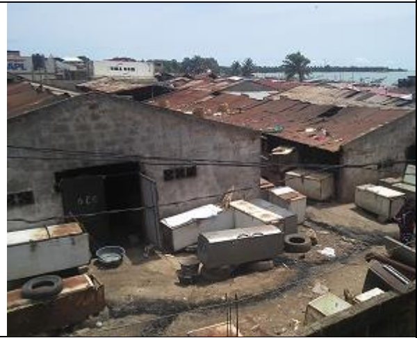
水揚場コンプレックス内の倉庫
