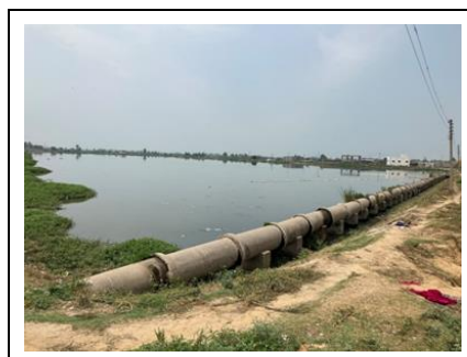
図 28：セプティックタンク汚泥を投入している下水処理場（ラグーン式）（ムザファルナガル）
