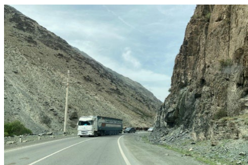
ビシュケクーオシュ道路の地すべり・落石危険地区（出典：評価者）
