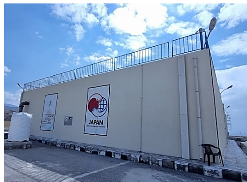
マアディ配水池（第一次）
