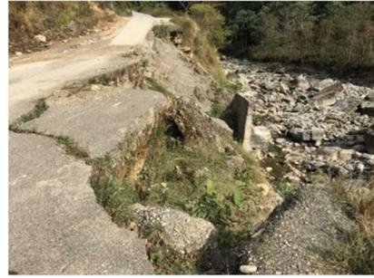
写真7 ラングルン河橋地点のアプローチ道路と擁壁一部の崩落箇所
